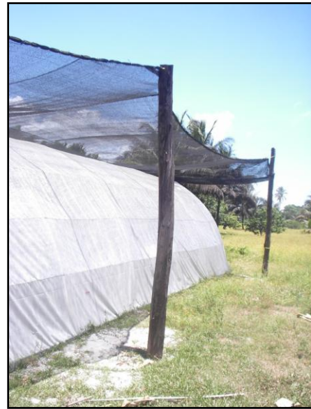
Photo 8 : Installation de l'ombrière sur la serre de sévage
